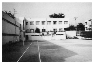
千里桃山寮(独身寮、大阪府吹田市)
