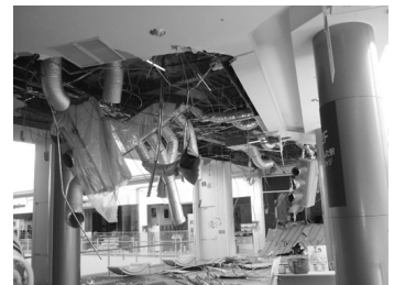
大型ショッピングモールの落下したダクトと配管 (2011年3月18日撮影)
