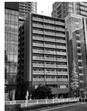
旧本社ビルの跡地に建設した学生寮
