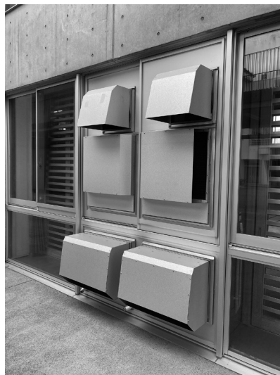
つくばみらい市立富士見ヶ丘小学校体育館に設置した空調換気システム外観。屋内(左)、屋外(右)
