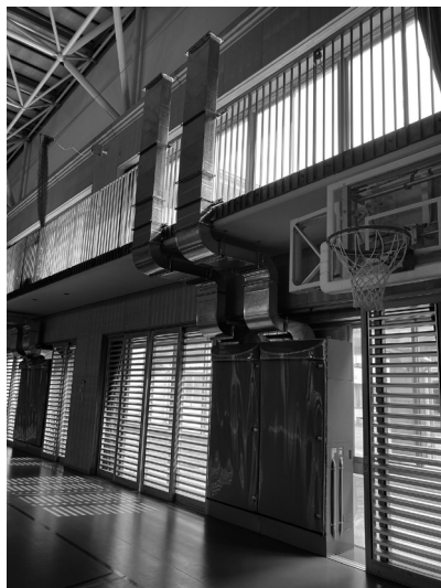
つくばみらい市立富士見ヶ丘小学校体育館に設置した空調換気システム外観。屋内(左)、屋外(右)
