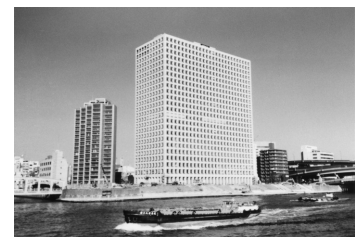
三井倉庫箱崎ビル
