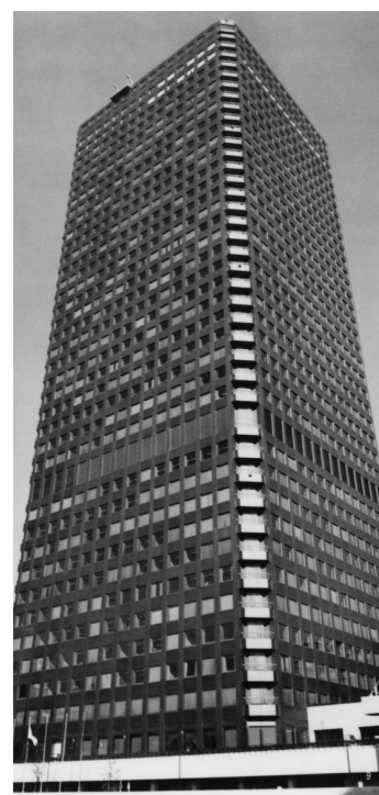
世界貿易センタービル
