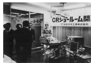
本社別館クリーンルーム展示室
