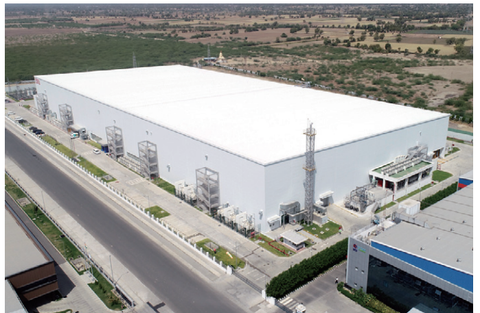
インド／TDSG グジャラートリチウムイオン電池工場 (2019年)
