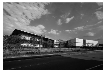
高砂熱学イノベーションセンター外観
