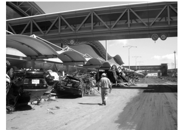
仙台空港の流された車 (2011年3月18日撮影)
