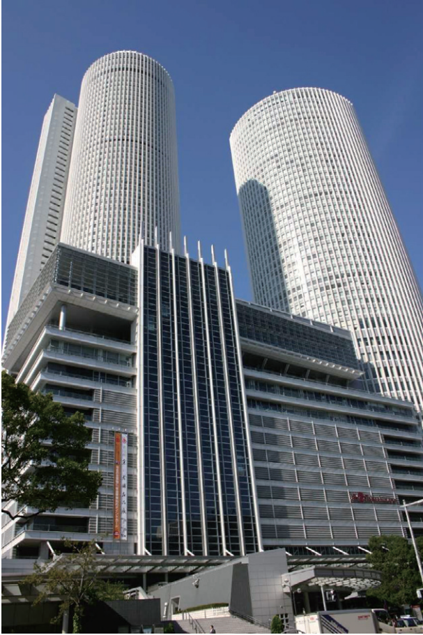
JRセントラルタワーズ (2000年)
