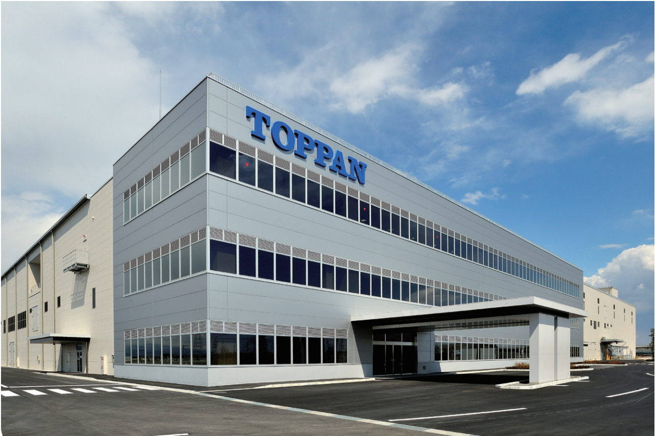
TOPPAN 群馬センター工場 (2014年)
