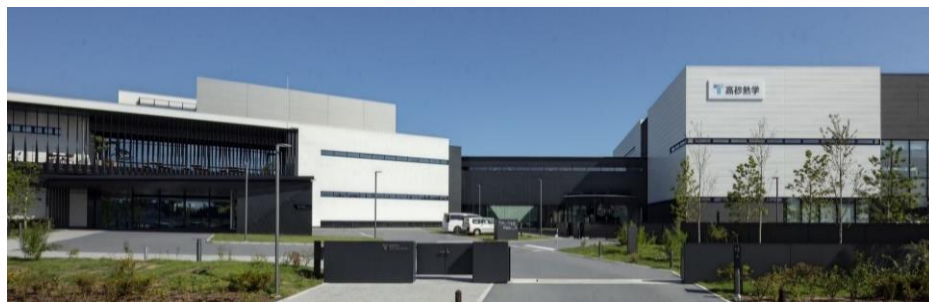
高砂熱学イノベーションセンター 外観
