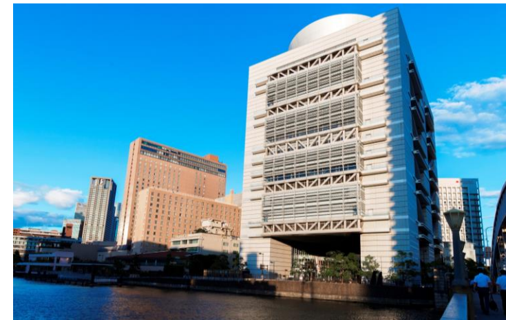
大阪国際会議場（グランキューブ大阪）
