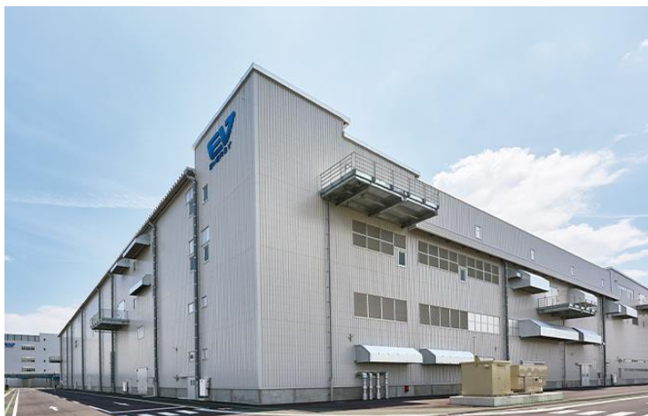
プライムアースEVエネルギー宮城工場 第4工場
