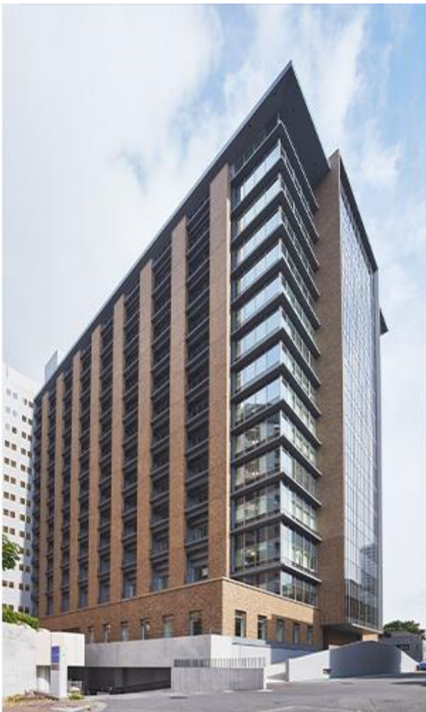
東京大学医学部附属病院 入院棟B
