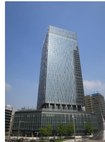
大名古屋ビルヂング
