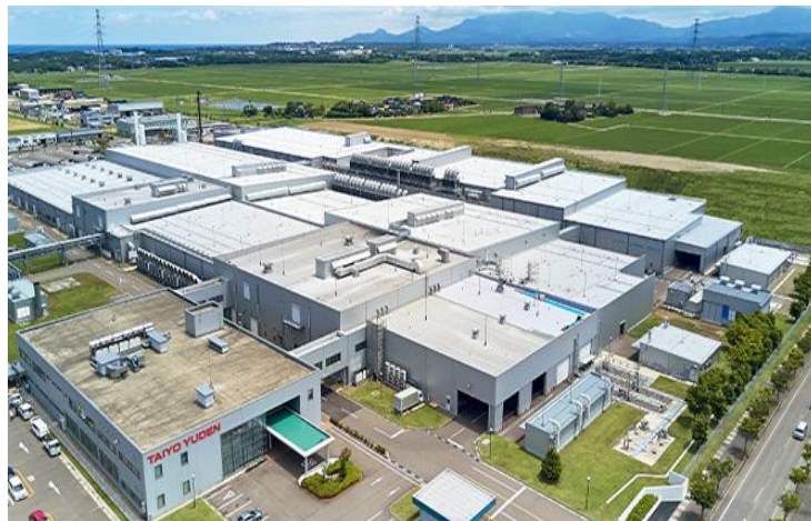
新潟太陽誘電株式会社第二工場3号棟
