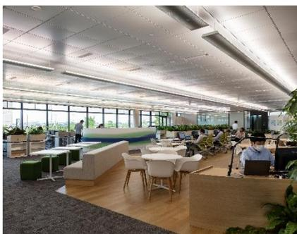
執務フロア。システム天井対応放射パネルを採用。平滑面に照明を反射させ、部屋の明るさ感の向上にも寄与する。
