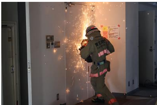
エンジンカッターを使用した防火扉の切断
