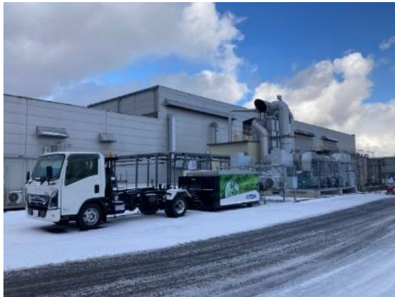
A: 排熱場所 外観(排熱を回収)
