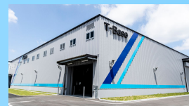
施工プロセスの変革 T-Base®プロジェクト
