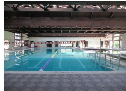
【熱利用側】 大手門温水プール(遊泳館) 秋田県由利本荘市尾崎23
