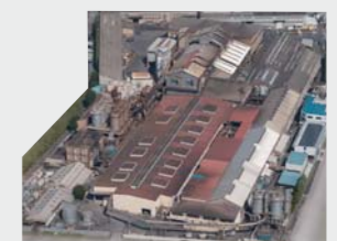
The Oyama Plant, Tokyo Kohtetsu co., ltd.
