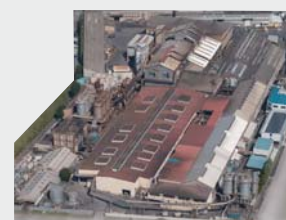
The Oyama Plant, Tokyo Kohtetsu co., ltd.
