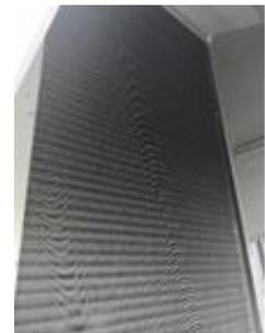
写真 19-3 徐霜運転(徐霜完了 15min)
