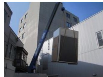
写真 16 室外機搬入状況
