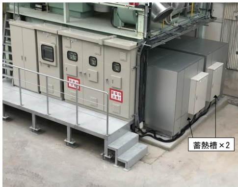
写真1 定置型実証設備
