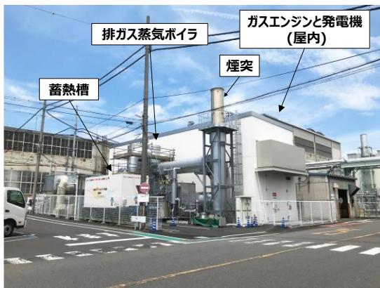
写真 3 コージェネレーションシステムの蓄熱サイト
