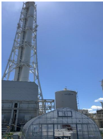
(A) 発電所の煙突とビニールハウス
