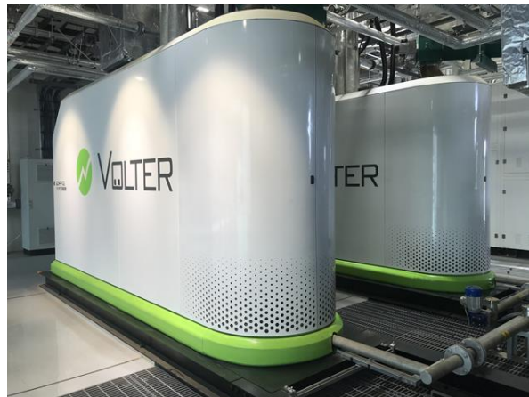
図 2 バイオマス CHP 外観
