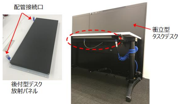
写真4 後付型デスク放射パネルの外観とコイル配管接続口
