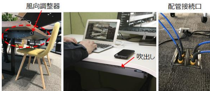
写真3 後付型タスクデスク空調機の外観とコイル配管接続口
