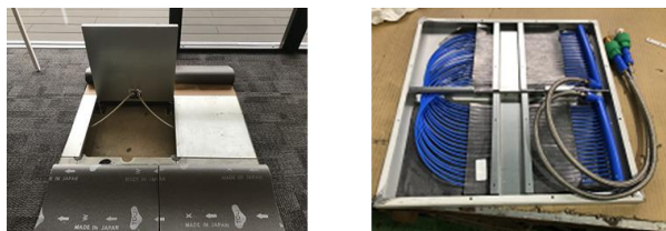
写真 5 OAフロア対応パネル空調の外観と内部
