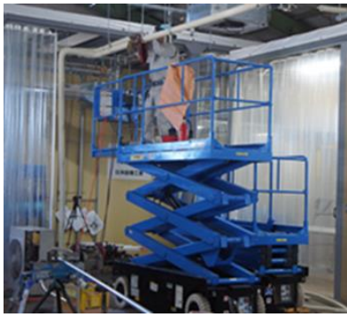
写真 6-1 室外機廻り配管施工状況(銅)
