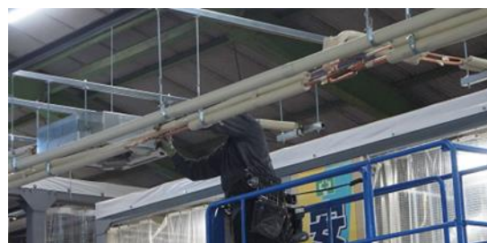
写真 8 銅配管の分岐管廻り施工状況
