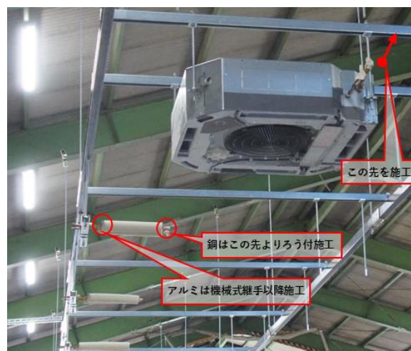
写真2 室内機の施工開始点
