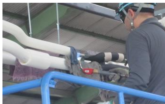
写真 11 アルミろう付施工状況
