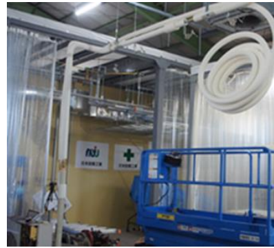
写真 6-2 室外機廻り配管施工状況(アルミ)
