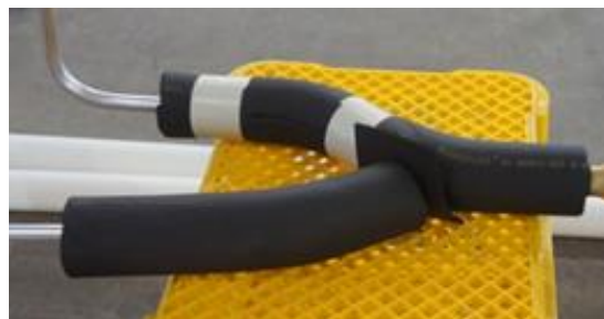
写真 15 アルミ機械式継手(左写真)とアルミ分岐管(右写真)の断熱状況
