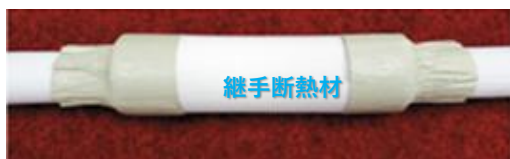
写真 13 断熱材の厚み 10 mm の場合の施工状況
