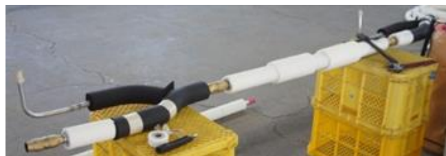
写真 9 地組によるアルミ分岐管廻り配管施工状況
