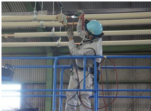
写真 7 銅配管のメイン管施工状況
