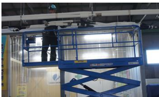
写真 10 アルミ分岐管廻り配管施工状況
