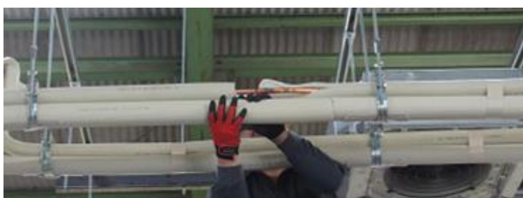
写真 12 銅配管の継手まわりの断熱材の補修作業
