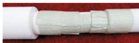
写真 14 断熱材の厚み 20 mm の場合の施工状況
