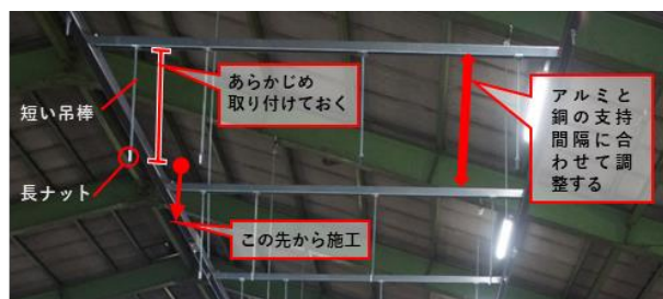
写真1 ダクターチャンネルの位置調整と施工開始点
