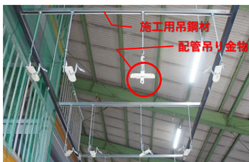
写真 5 吊り金物の取付状況
