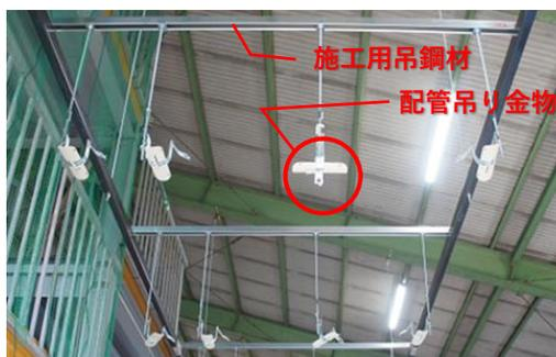
写真5 吊り金物の取付状況
