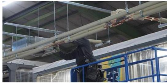
写真 8 銅配管の分岐管廻り施工状況
