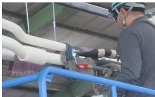
写真11 アルミろう付施工状況
