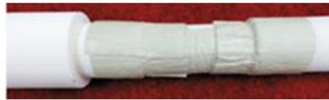
写真 14 断熱材の厚み 20 mm の場合の施工状況
