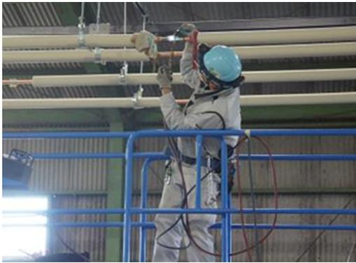
写真 7 銅配管のメイン管施工状況
