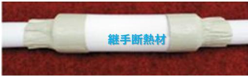
写真 13 断熱材の厚み 10 mm の場合の施工状況
