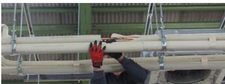
写真12 銅配管の継手まわりの断熱材の補修作業
