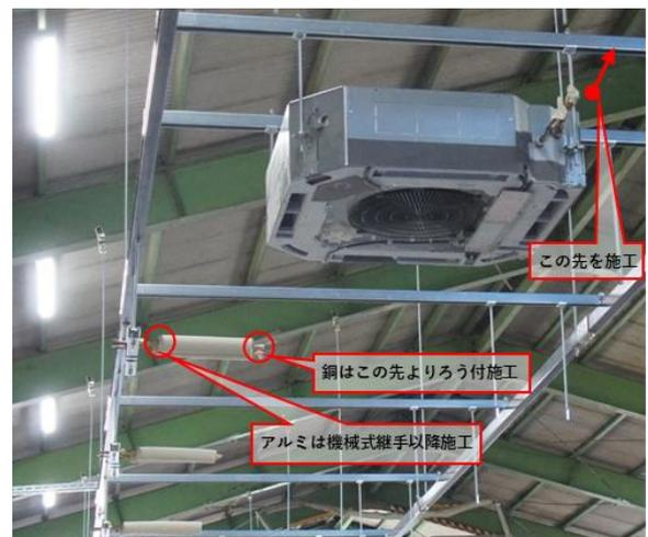
写真2 室内機の施工開始点
