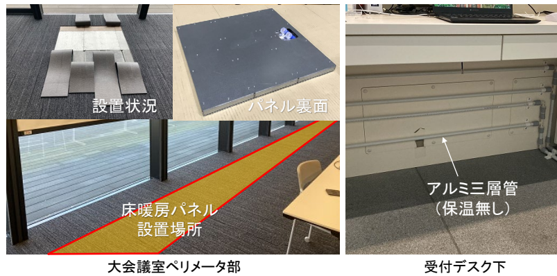
写真 2 大会議室の床暖房パネル設置状況と受付局所暖房
