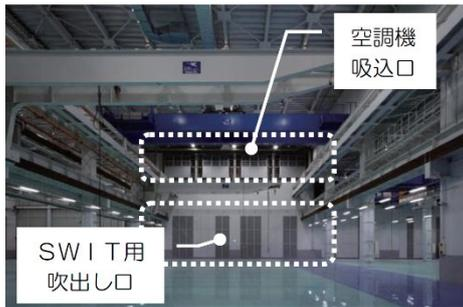
図 23 旋回流誘引型壁吹出方式<sup>21)</sup>
