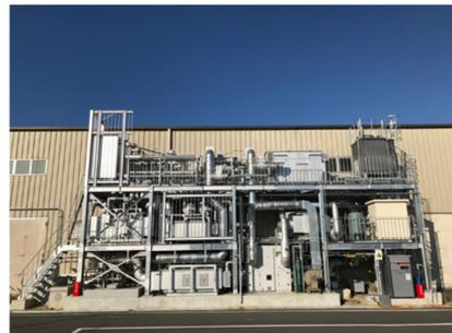
図 12 クローズド VOC 回収装置<sup>8)</sup>
