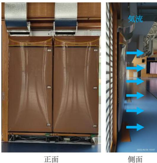
図2 ビニール風船型吹出し口の設置状況
