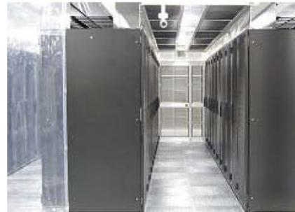
図 24 データセンターの壁吹出方式<sup>26)</sup>
