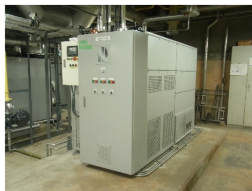
写真3 実証機の実証建物への設置
