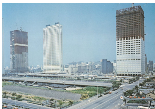
図 38 地域冷暖房施設が施工されている 1970年当時の新宿新都心エリア 1)
