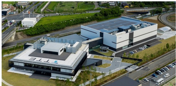
図 4 高砂熱学イノベーションセンター(つくばみらい市) 2)
