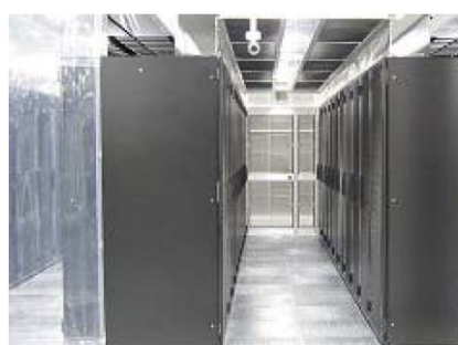
図 24 データセンターの壁吹出方式 26)
