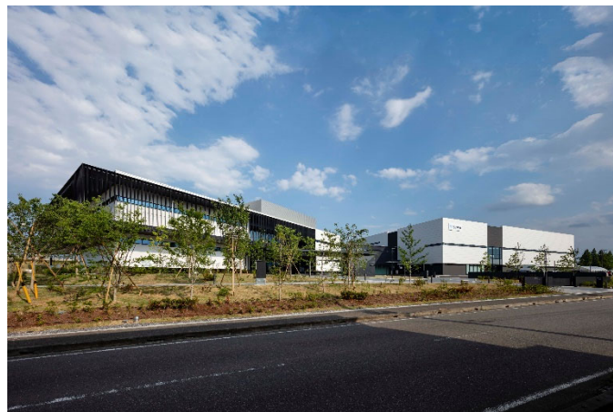
写真1 高砂熱学イノベーションセンター
