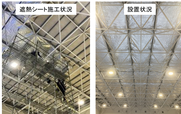
写真4 遮熱シート設置状況
