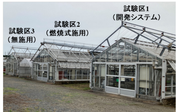
写真 3 ガラスハウス(床面積 100m 2 ×3 棟)
