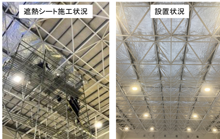
写真4 遮熱シート設置状況
