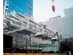
大規模シャフトユニット工法 冷却水配管、冷水配管。
