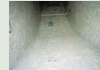
作業後のダクト内部
