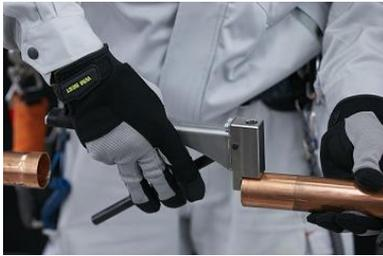
【写真4 窒素ガス封入口の穴あけ】
