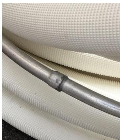
【写真1 アルミ冷媒配管のろう付接合】
