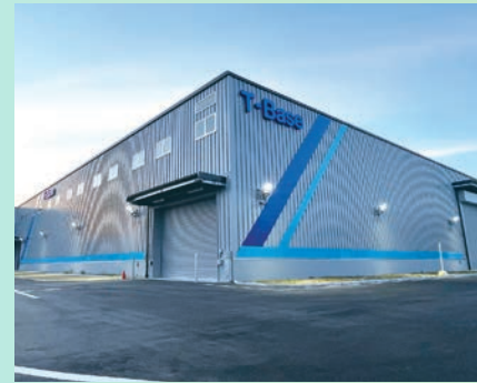
施工プロセスの中核施設 T-Base®
