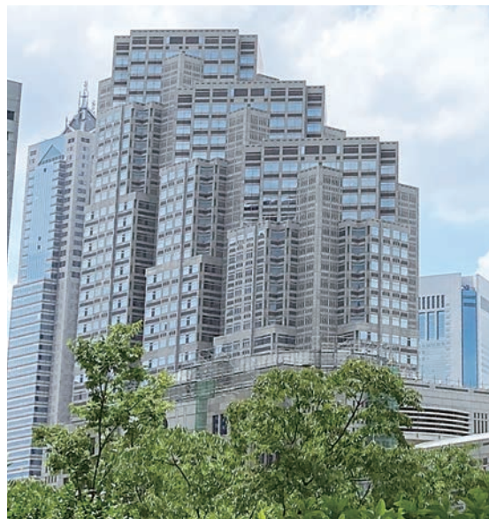
東京都庁舎の改修工事
