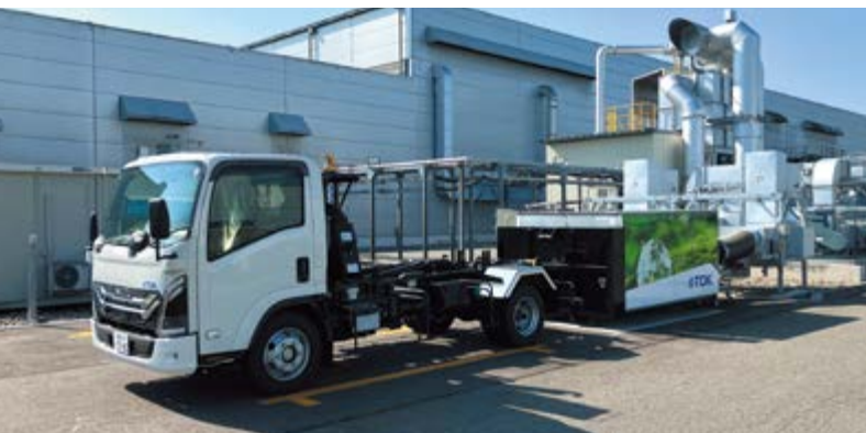
A 排熱場所 外観(排熱を回収)
