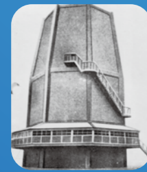
国産第一号の冷却塔
