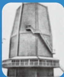
国産第一号の冷却塔
