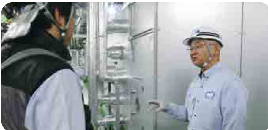
社長による現場安全パトロール
