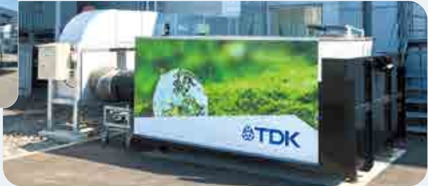
B 利用場所 外観 (運んだ排熱を利用)
