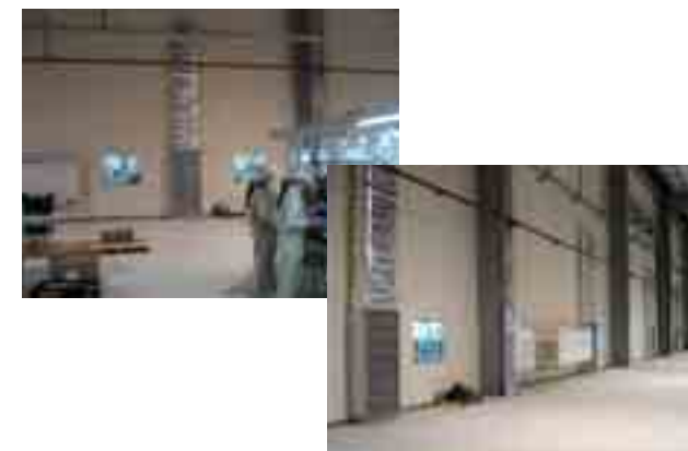
SWITの施工例
