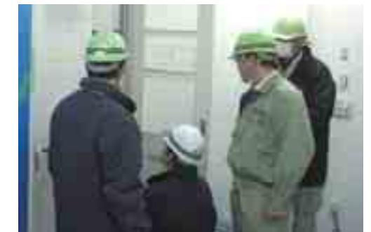
施工現場での調査
