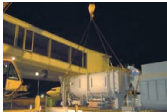
仙台空港復旧作業
