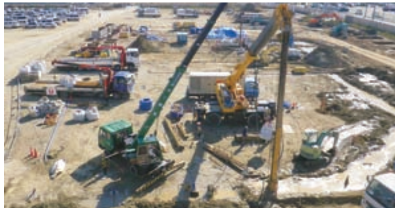
地中熱利用システム施工時
