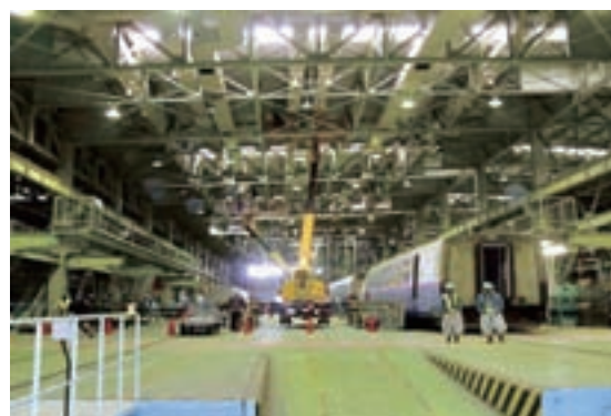
新幹線車両基地復旧作業
