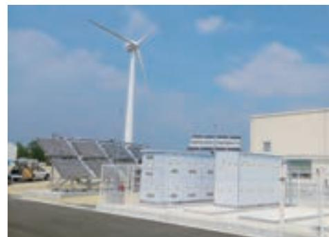
独立行政法人産業技術総合研究所の福島再生可能エネルギー研究所における太陽熱蒸気供給システム(左手奥)と水素利用型蓄電装置(中央から右手前のユニット)
