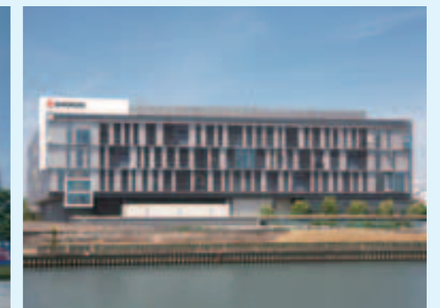
塩野義製薬医薬研究センター (社団法人 空気調和・衛生工学会 第52回学会賞技術賞「建築設備部門」受賞)
