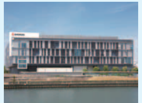
塩野義製薬医薬研究センター (社団法人 空気調和・衛生工学会 第52回学会賞技術賞「建築設備部門」受賞)
