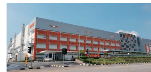
OSRAM: 新工場建築工事一式が竣工
