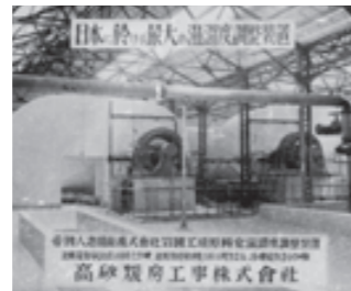
1927年 日本初の本格温湿度調整装置 (帝国人造絹糸(株)[現・帝人(株)]岩国事業所)
