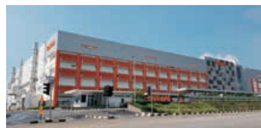
OSRAM: 新工場建築工事一式が竣工
