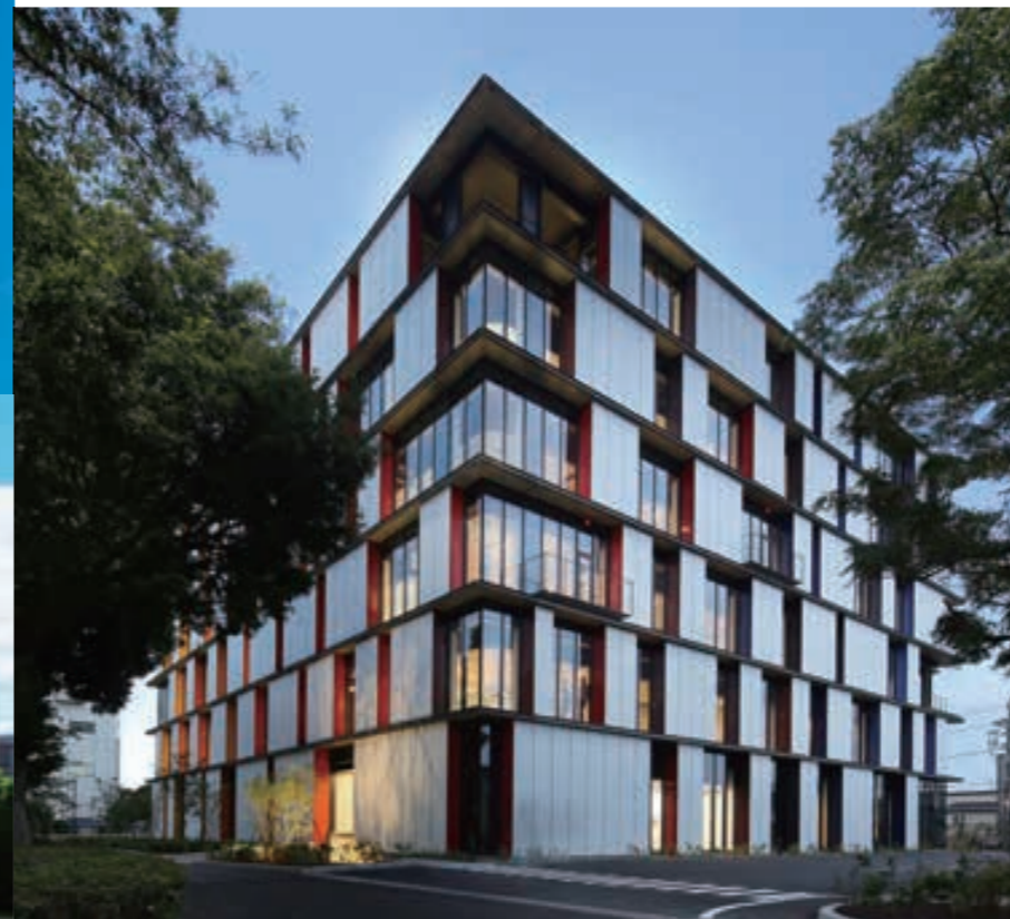
日本無線川越事業所 【撮影：野田 東徳（公社）空気調和・衛生工学会 第33回振興賞「技術振興賞」、（社）建築設備技術者協会第7回「カーボンニュートラル賞」受賞】
