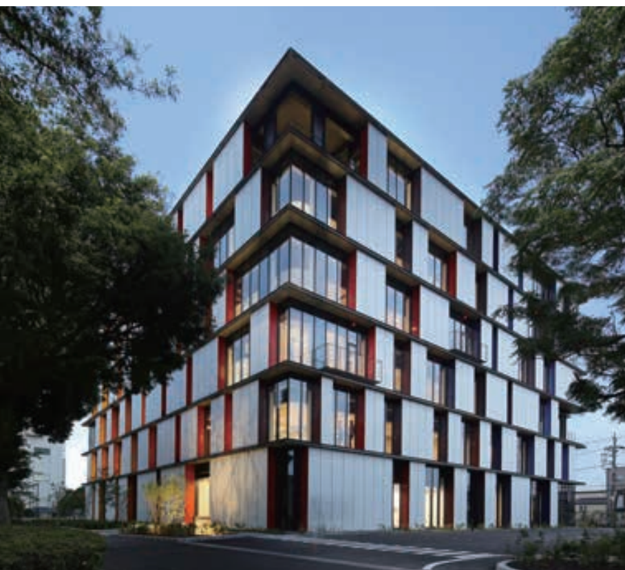
日本無線川越事業所 【撮影：野田 東徳（公社）空気調和・衛生工学会 第33回振興賞「技術振興賞」、（一社）建築設備技術者協会第7回「カーボンニュートラル賞」受賞】
