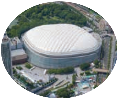
1988年 東京ドーム 日本初のエア・サポータード・ ドーム スタジアム空調 協力:株式会社東京ドーム
