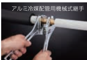
アルミ冷媒配管
