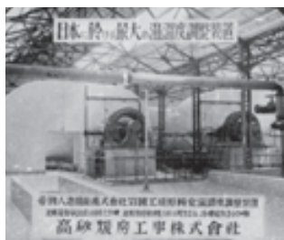
1927年 日本初の本格温湿度調整装置 (帝国人造絹糸(株)〔現・帝人(株)〕岩国事業所)
