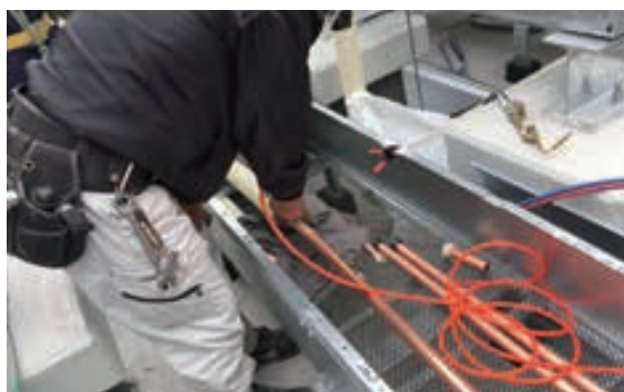
エルブレイズ工法施工の様子
