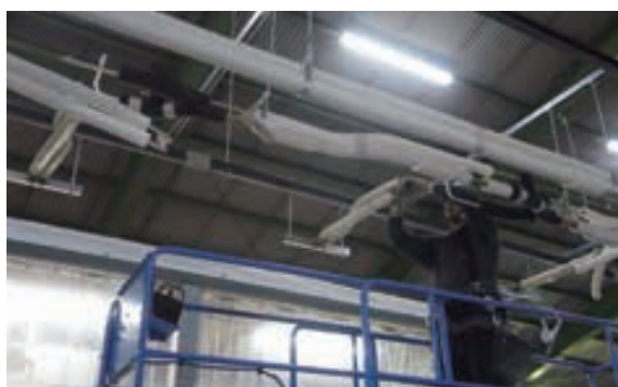
アルミ冷媒配管の施工の様子
