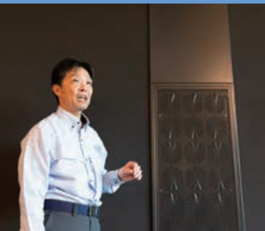
カフェテリアの壁に設置された置換空調パネル「SWIT®」
