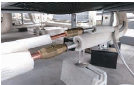
アルミ冷媒配管用機械式継手の施工状況
