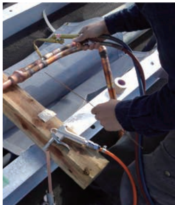
エルブレイズ工法施工状況
