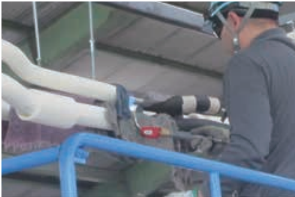
アルミ管のろう付施工状況
