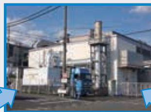
工場内コジェネシステム →排ガス(160℃)と 排温水(80℃)から 熱回収
